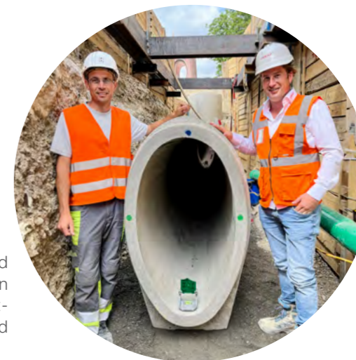
Bauleiter Sebastian Jacobs (Münchner Stadtentwässerung, l.) und Krystian Trybus (Geiger Netzbau) sind überzeugt von den HABA-Betonteilen.
