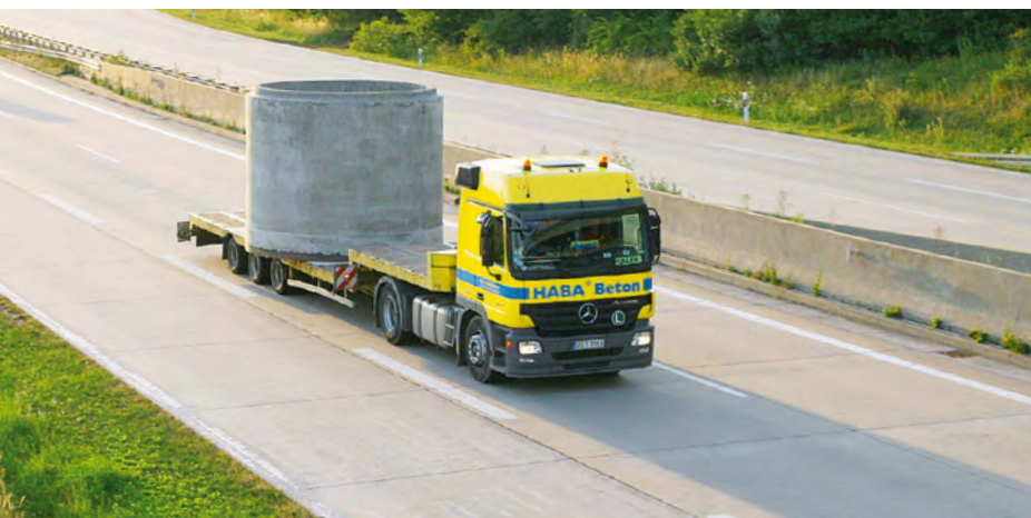
Transport von Elementen zur Baustelle
