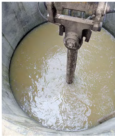
Betonieren der Unterwasserplombe
