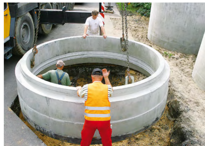
Problemlose Montage durch spezielle Anker
