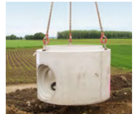
Alle Schachtunterteile stellen wir mit drei eingegossenen Verlegeankern aus. Sie sorgen für ein sicheres Handling auf der Baustelle.
